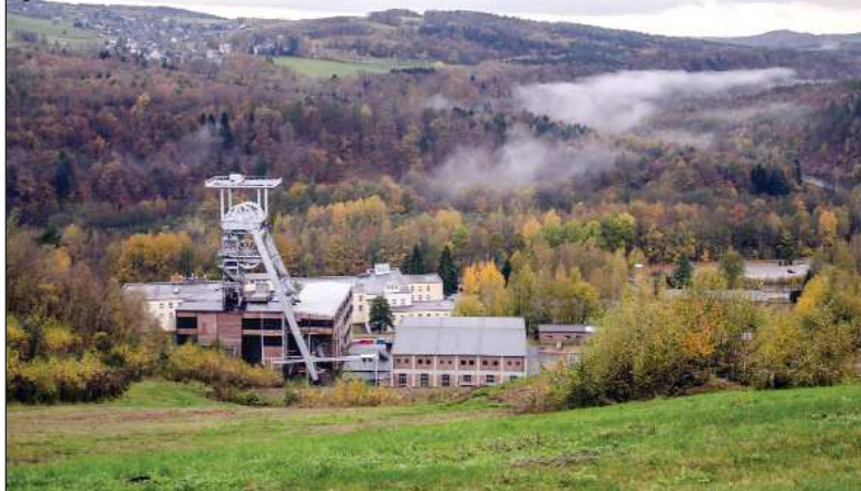
Areál šachty 371, Hartenstein, sídlo pobočky podniku Wismut GmbH pro oblast Aue
