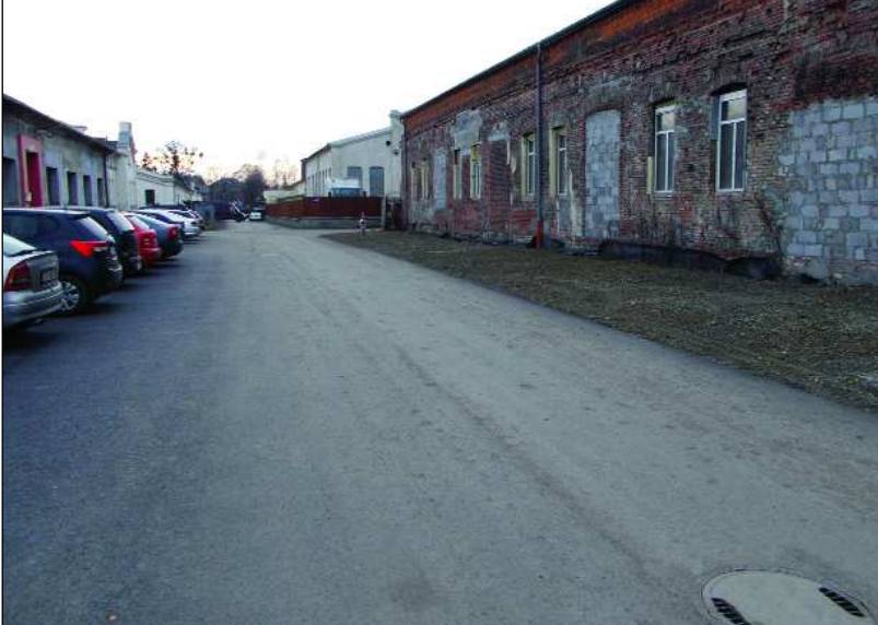
Část zrekonstruované komunikace
