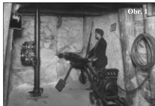
Obr. 1 - Vlevo elektrické vrtací kladivo AEG, vpravo pneumatické kladivo s kompresorem Ingersoll-Rand ve staré expozici TM. Obě zařízení se předváděla v chodu již v roce 1913. Dar firem AEG a Ingersoll-Rand, cca 1912. Foto: archiv NTM
