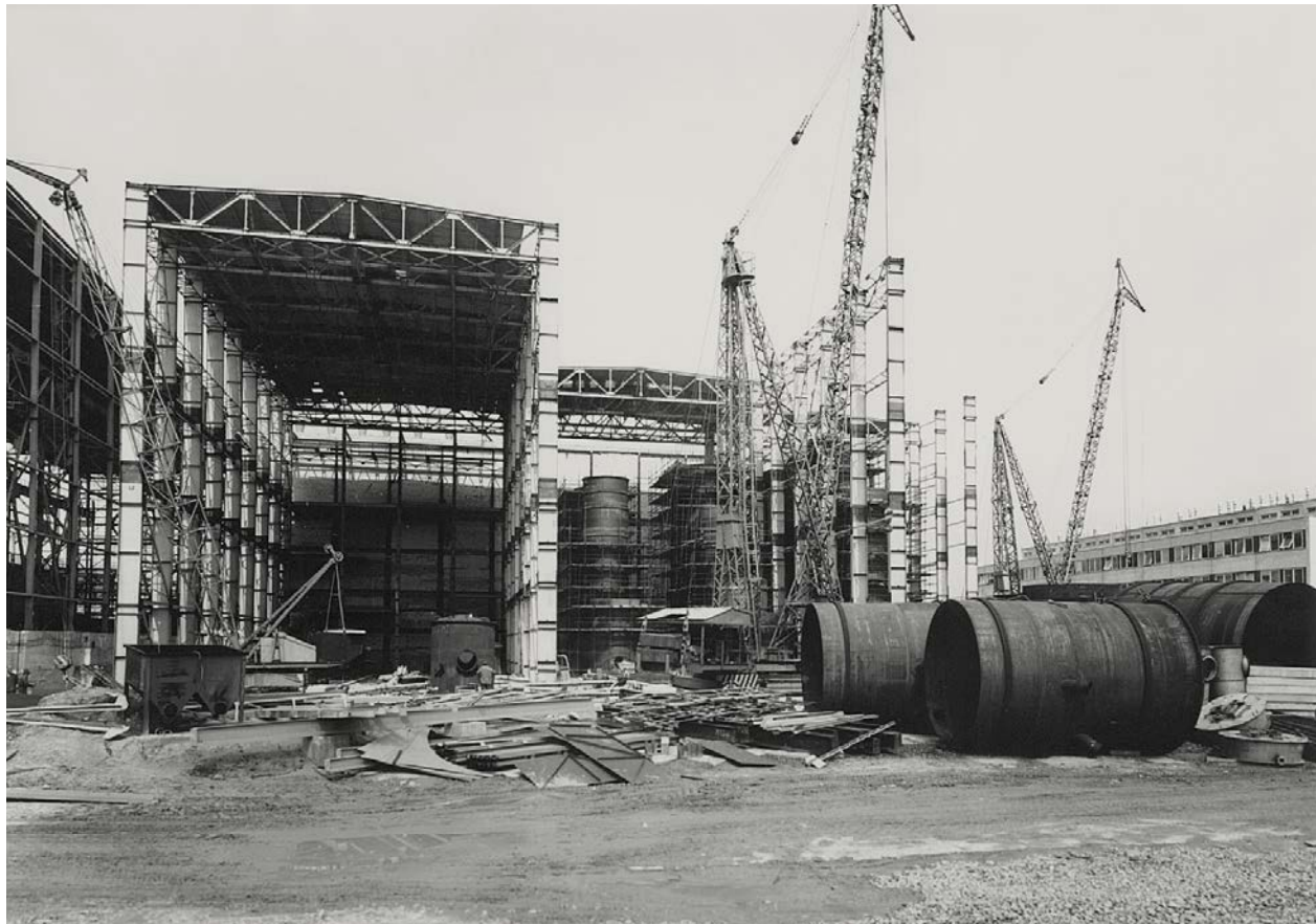
Výstavba hydrometalurgického cechu
