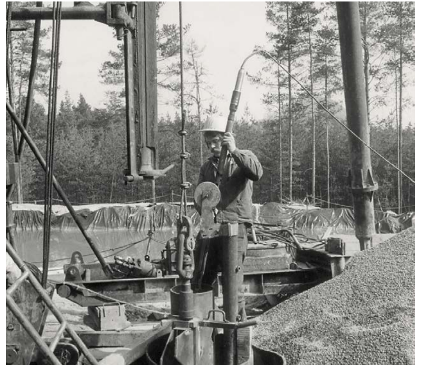
Zapouštění kavernoměru do vrtu
