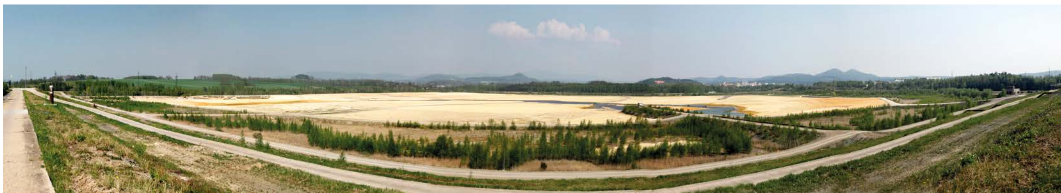
Zatěsňování dna II. etapy odkaliště pomocí neutralizačních kalů
