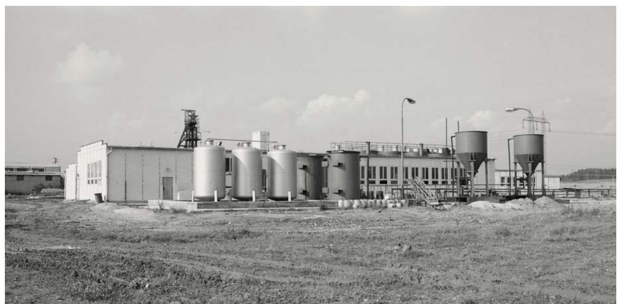
Spiraktory u hloubené jámy č. 3 Dolu Hamr I
