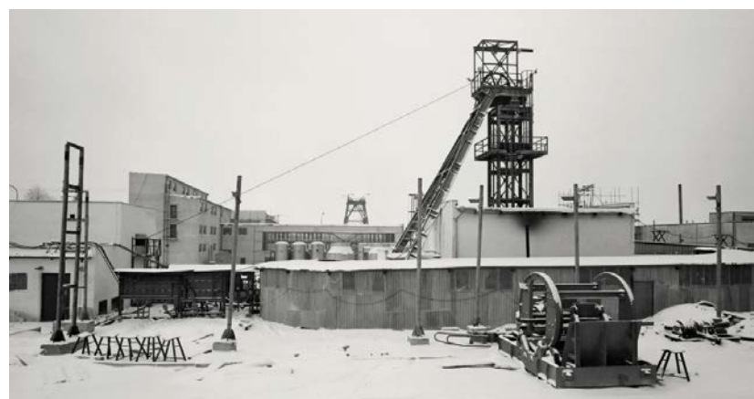
Výstavba povrchu Dolu Křižany I, v popředí jáma č. 5
