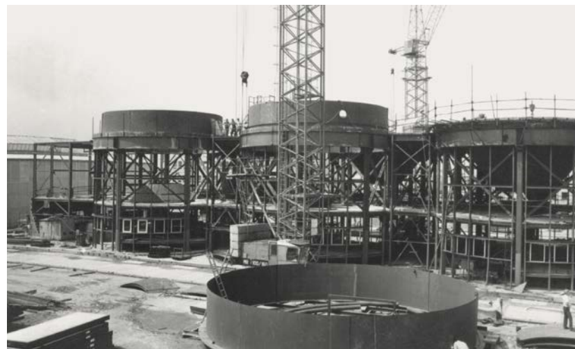
Výstavba centrální dekontaminační stanice
