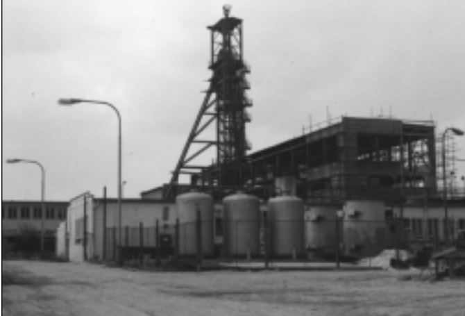
Výstavba těžní věže jámy č. 3, 2. polovina 70. let 20. století
