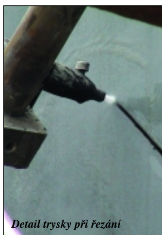
Řezání potrubí
