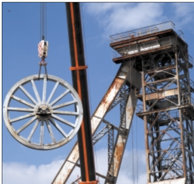
Postupné rozebírání konstrukce věže
