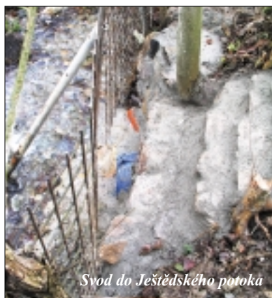
Průběh prací na stavbě odvodnění
