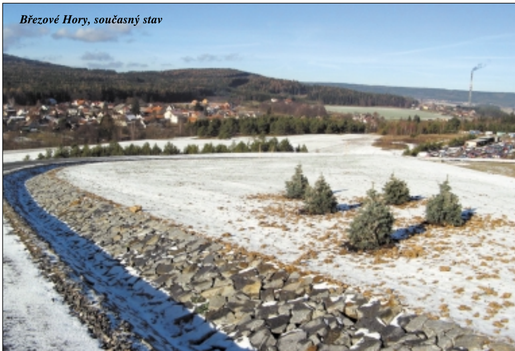
Sanace odkaliště KI - 1. etapa
