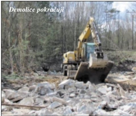
Drcení betonu a hromada železného šrotu
