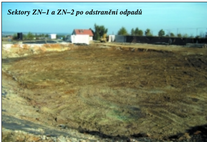
Odstraňování kontaminovaného podloží a drenáží v ZN-1
