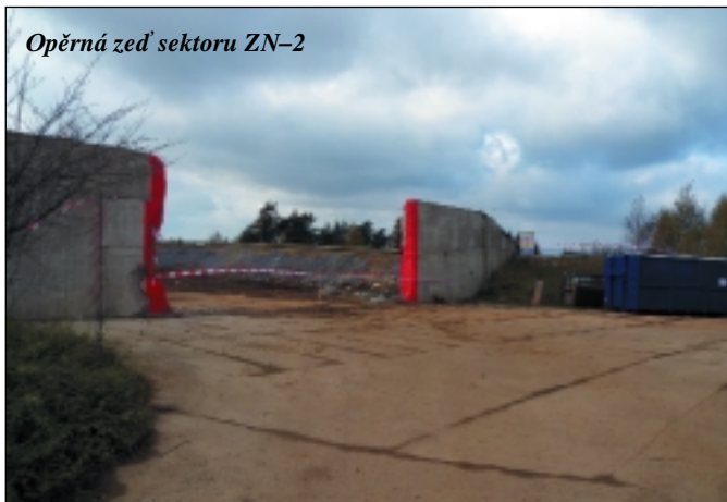
Bourání opěrné stěny sektoru ZN-2 – červenec 2011
