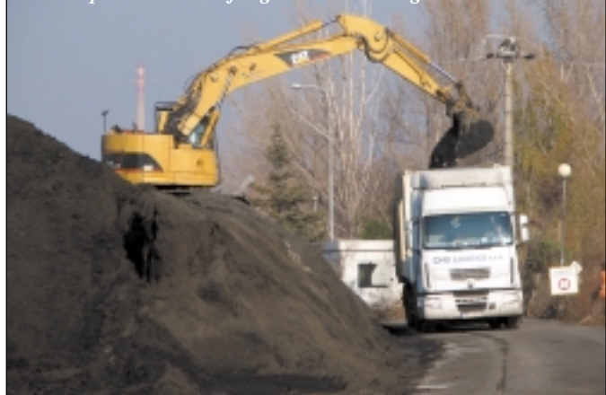
Nakládání paliva GEOBAL 4 do kontejneru typu Wood Tainer XXL společnosti Inno freight na lokalitě lagun v Ostravě
