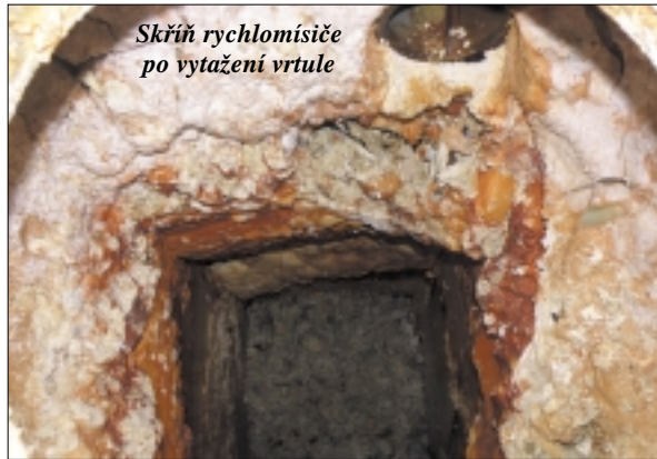
Spuštění přírubou o průměru 0,37 m do skříně rychlomíše
