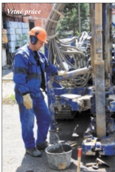
Vrtání nevystrojených průzkumných vrtů v areálu CDS pomocí hydraulické vrtné soupravy HVS 496, vrtné práce provádí společnost DEKONTA, a. s.
