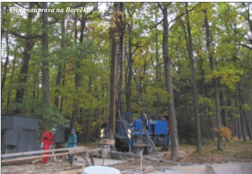
Příprava proplachu pažnic
