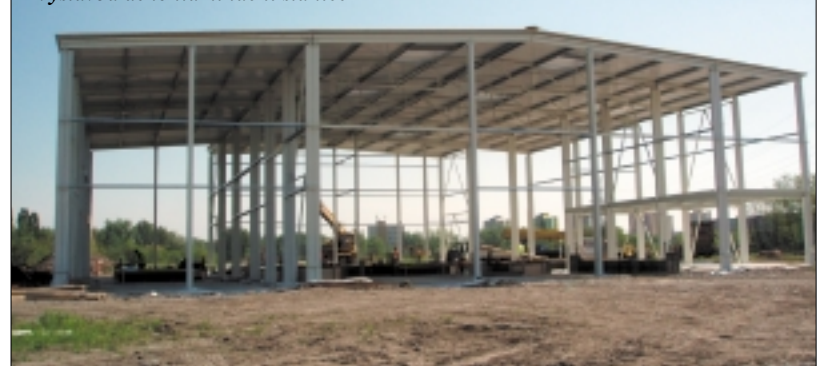
Výstavba dekontaminační stanice
