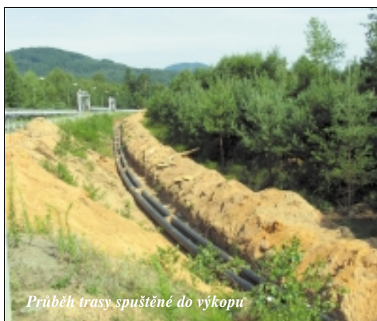
Montáž předizolovaného potrubí ukládaného do výkopu
