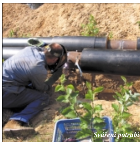
Montáž nadzemního úseku horkovodu
