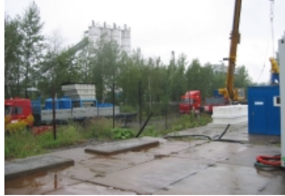
Dekontaminační stanice Aquatest, a. s.
