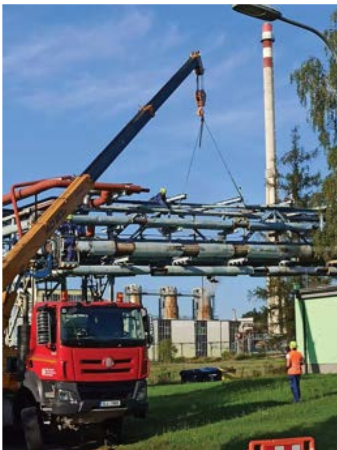
Obrázek č. 6-1: Likvidace části stavby „Potrubní most CHÚ“
