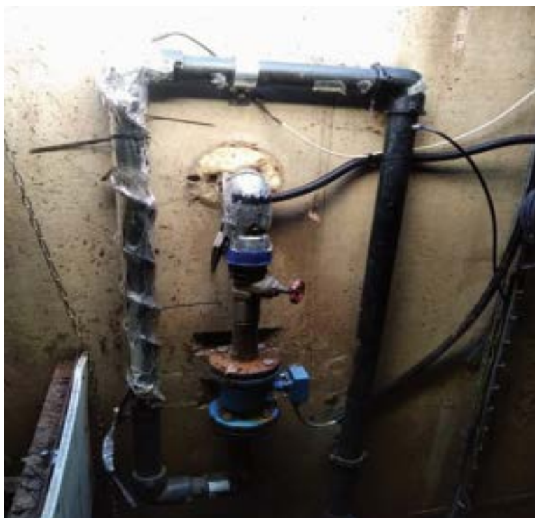
Obrázek č. 1-5: Nové výtlačné potrubí DN VP 7
