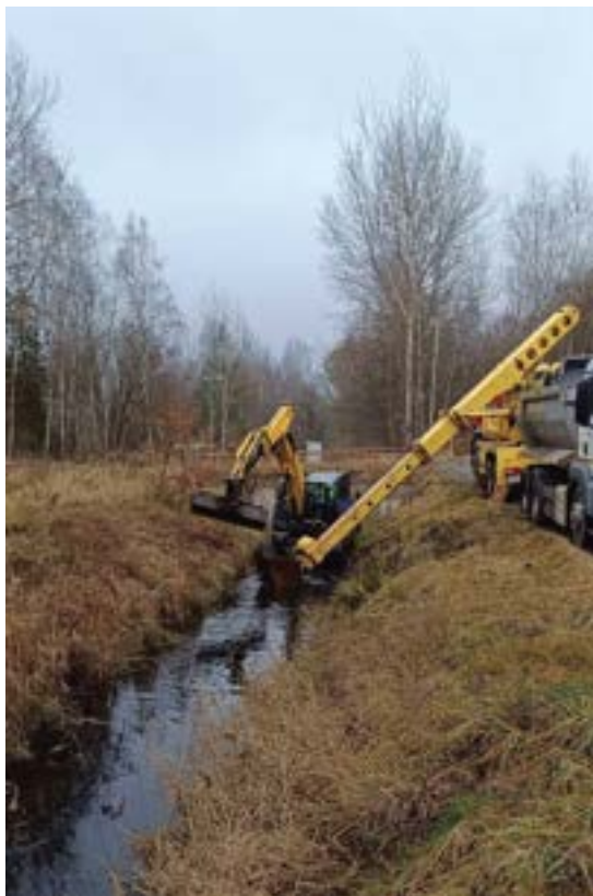
Obrázek č. 1-14: Čištění koryta obtokového kanálu
