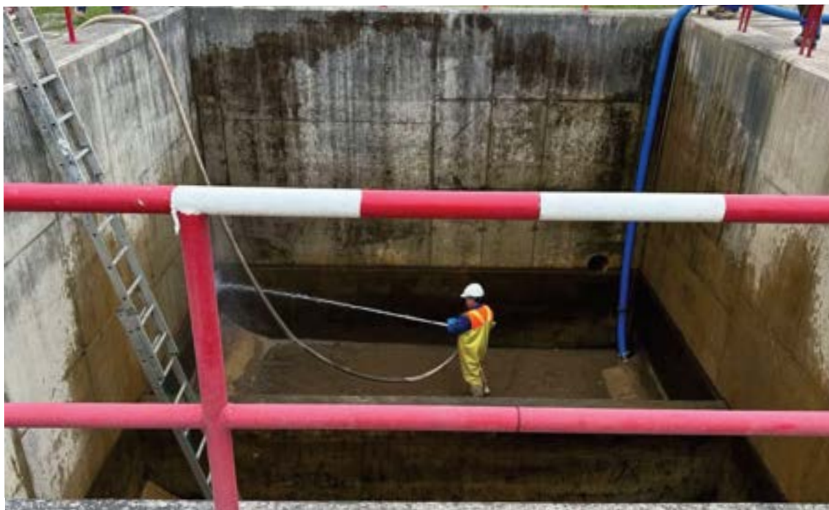
Obrázek č. 1-6: Čištění sedimentační a akumulční jímky SEDJ ML
