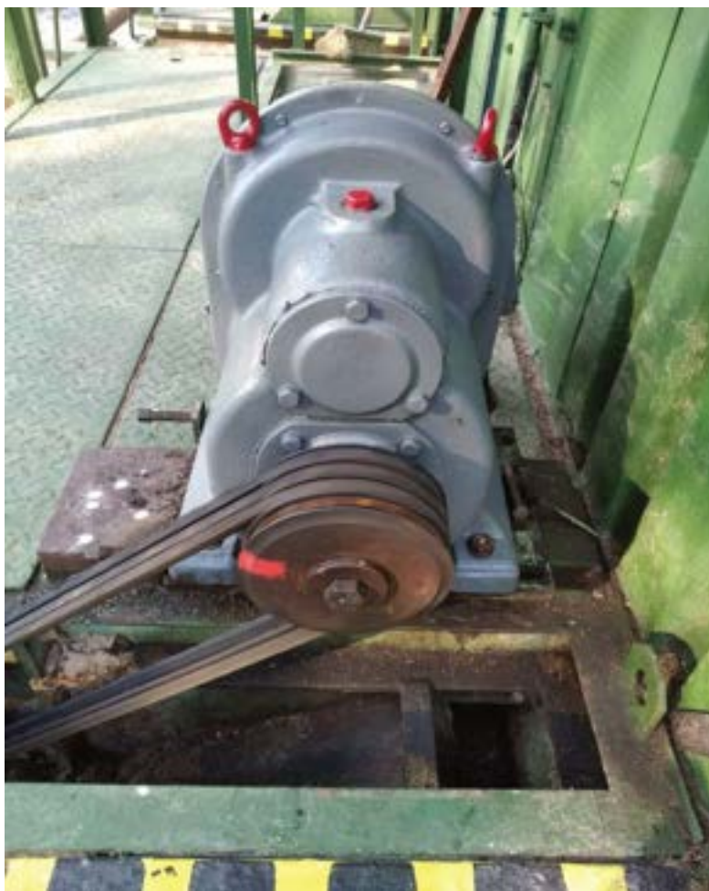
Obrázek č. 1-4: Vyměněný motor s převodovkou ČOV CHÚ
