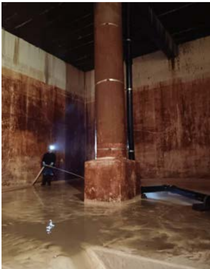
Obrázek č. 1-1: Čištění vodojemu Lipka
