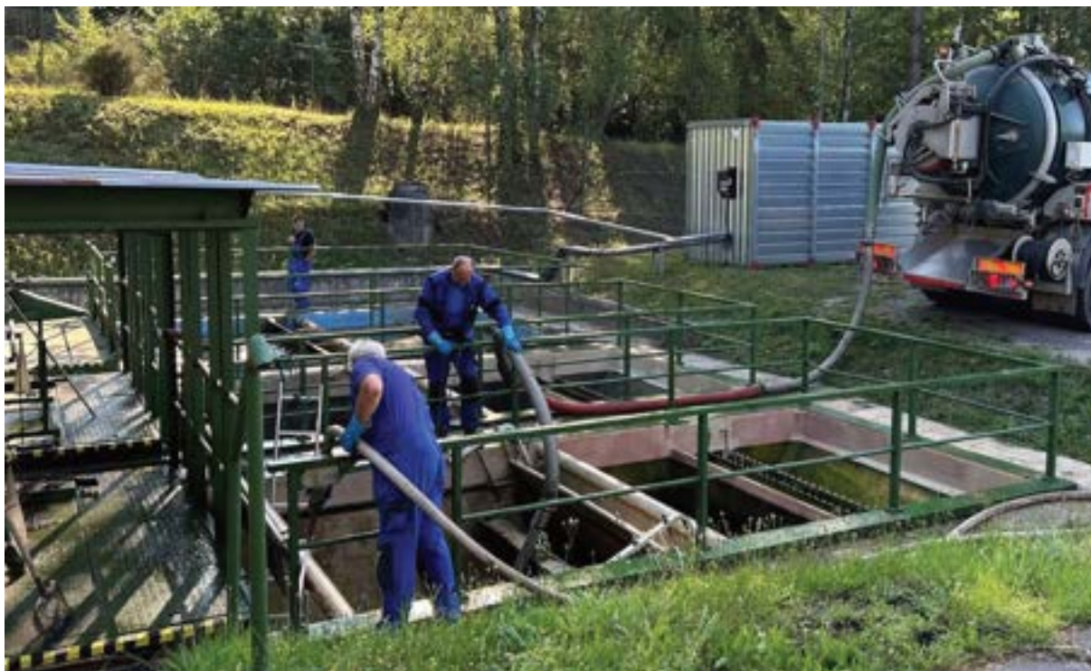
Obrázek č. 1-3: Čištění ČOV CHÚ
