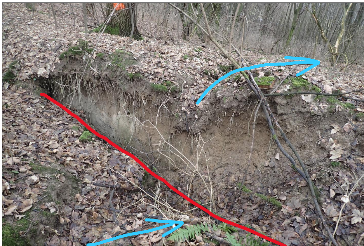
Obrázek č. 6 – SD 3 – Místo číslo 2. křížení odvodňovací rýhy a podélné trhliny
