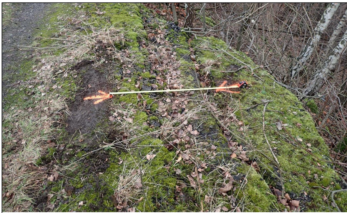
Obrázek č. 9 – SD 6 – Poškozená krajnice polní cesty
