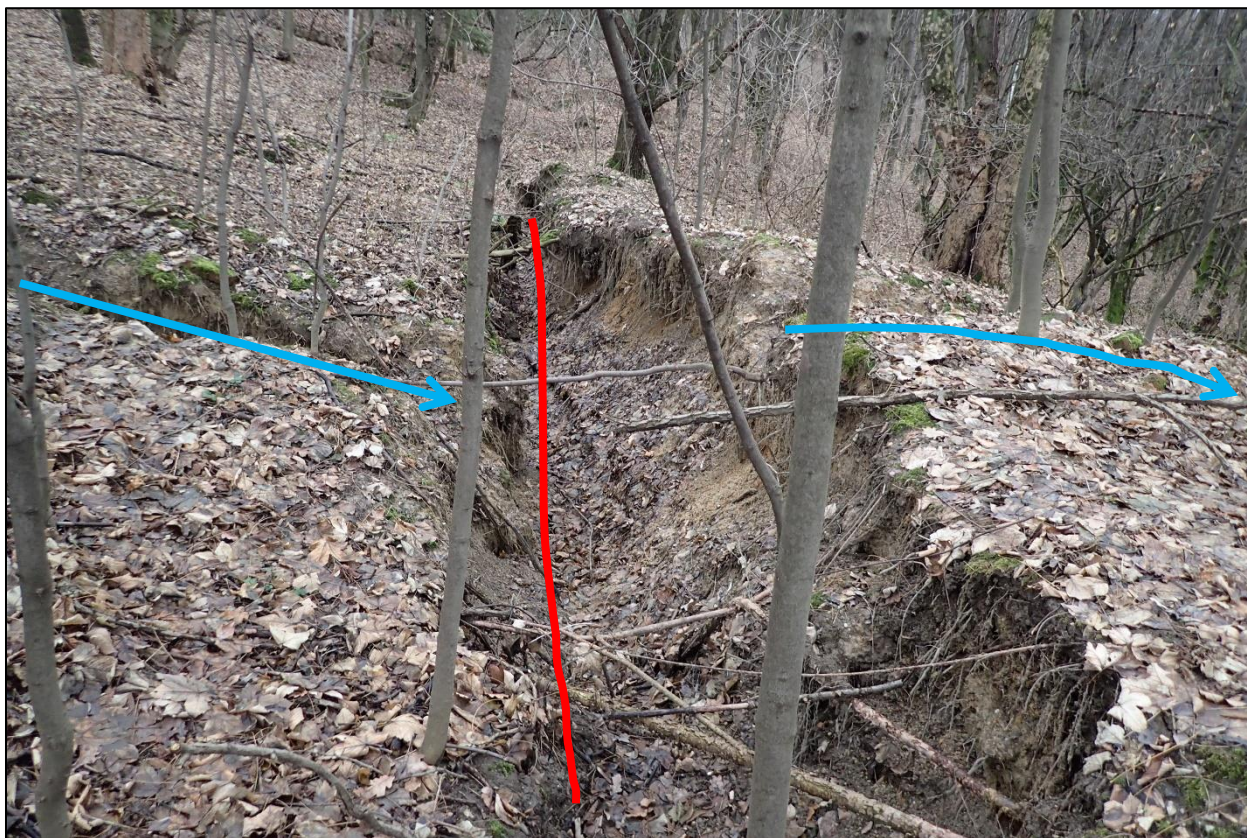
Obrázek č. 6 – SD 3 – Místo číslo 2. křížení odvodňovací rýhy a podélné trhliny
