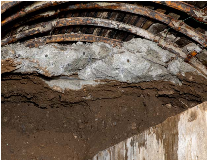
Betonová vrstva v čelbě s připravenými expandéry
