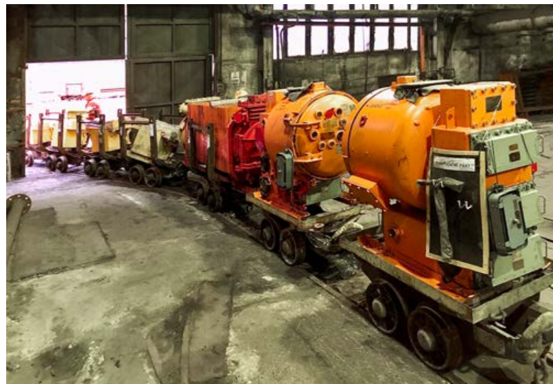
Trafa a rozvaděče připravené na odvoz do Zlatých Hor.
