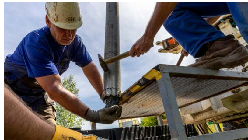
Pracovníci vrtného úseku o. z. TÚU vytloukají vrtné jádro z jádrovky
