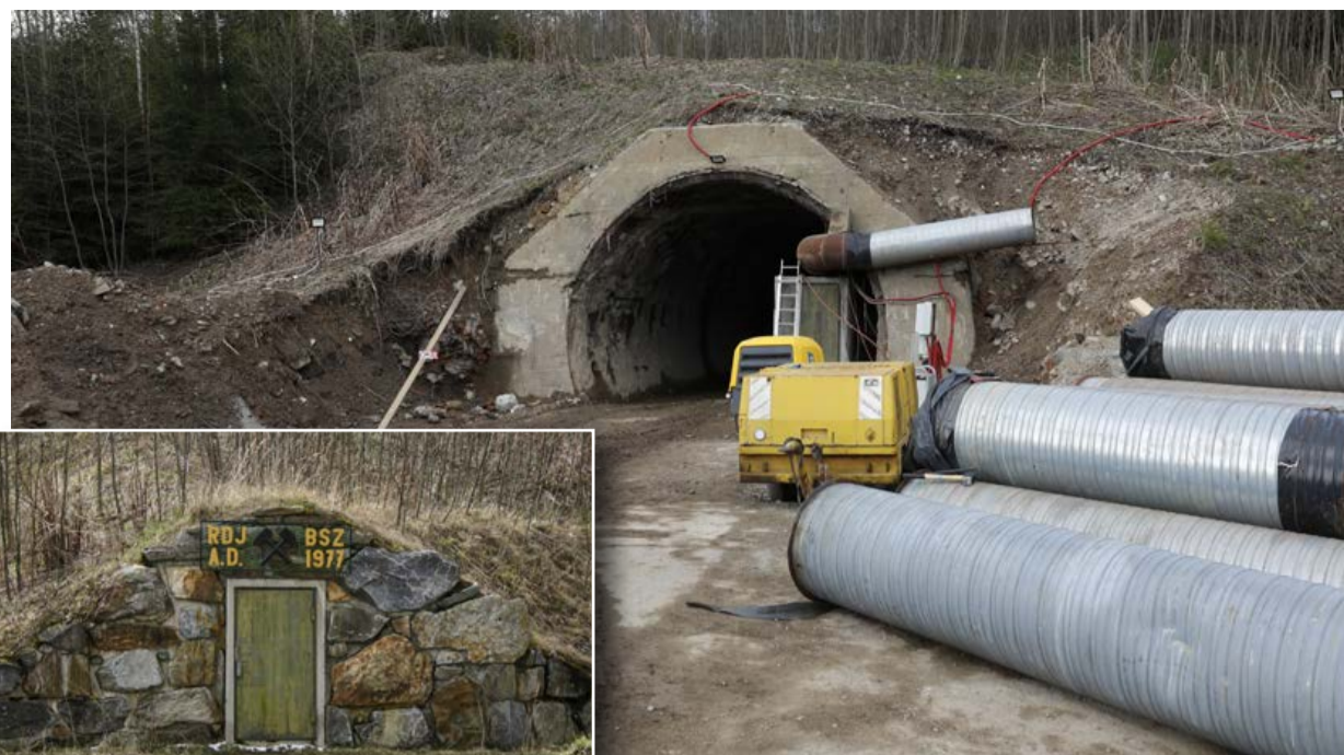
Odkryté původní ústí úvodní úpadnice ÚÚ2401 ze 70. let minulého století s vyústěním lutnového tahu důlní ventilace
