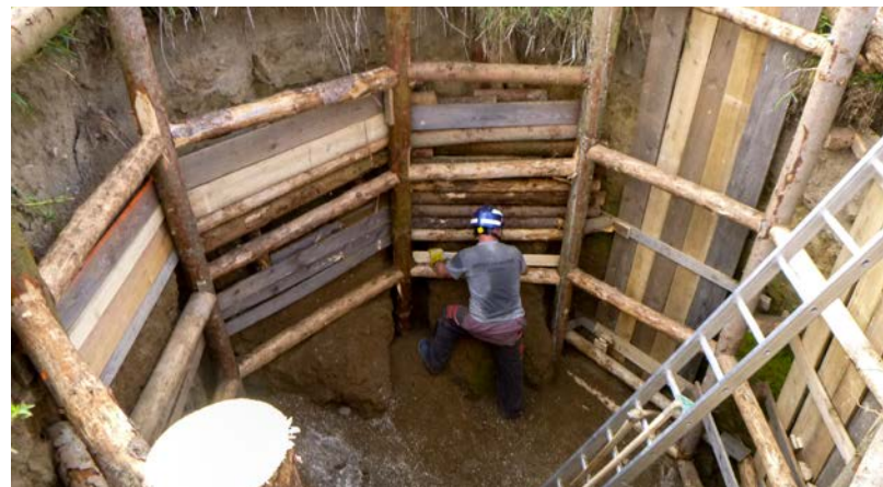
Štola Barbora – zajišťování stěn propadu
