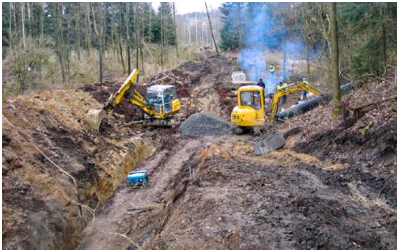
Stavba odtokového kanálu
