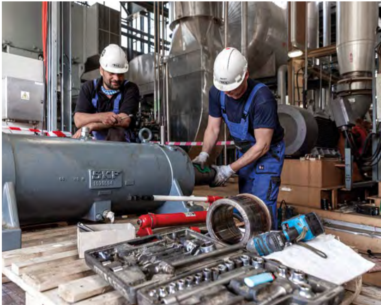
Na výměně ložiska spolupracovali i zaměstnanci o. z. TÚU
