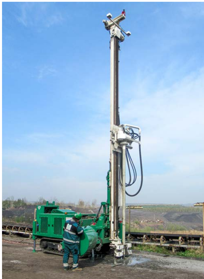
Vrtná souprava na heřmanickém odvalu
