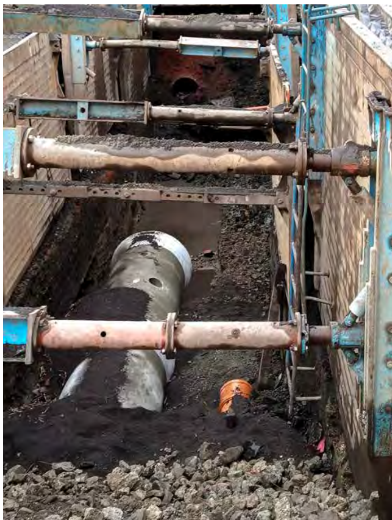
Uložení jednotné splaškové kanalizace a dešťové kanalizace
