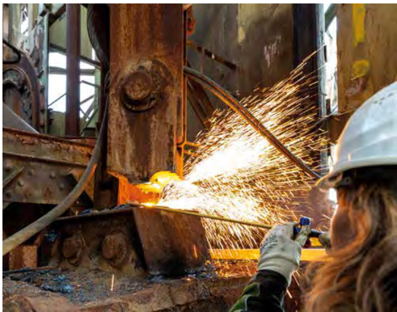
Řezání konstrukce těžní klece
