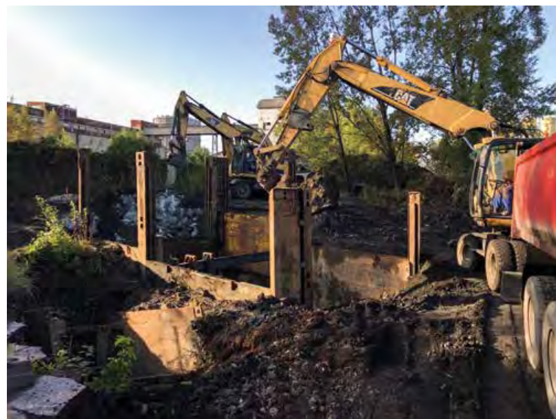
Stavba čerpací stanice: vpředu – ochranné ocelové pažení, vzadu – bourací práce železobetonových konstrukcí
