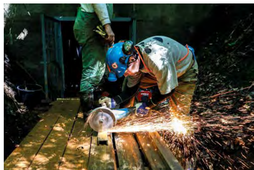
Pracovníci ZBZS o. z. GEAM při práci před vstupním portálem štoly
