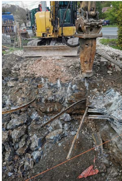
Pikování původního překrytí komína
