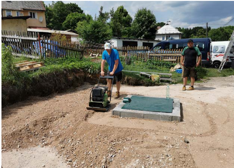
Hutnění navážky – uprostřed dosýpací otvor
