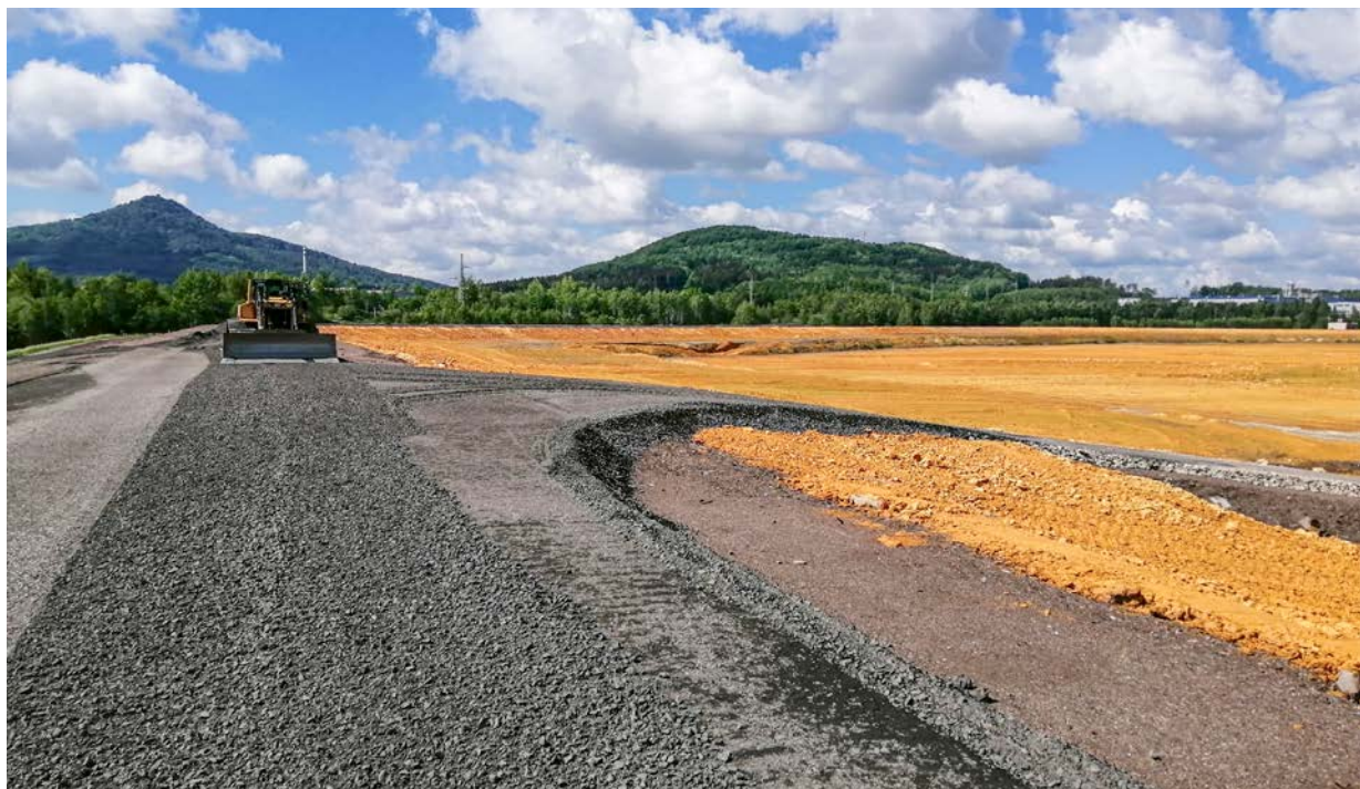
Výstavba obslužné komunikace na hrázi II. etapy odkaliště
