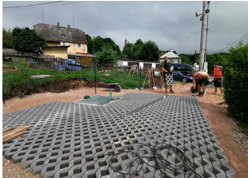
Dokončování prací pomocí položení zatravnovacích tvárnic
