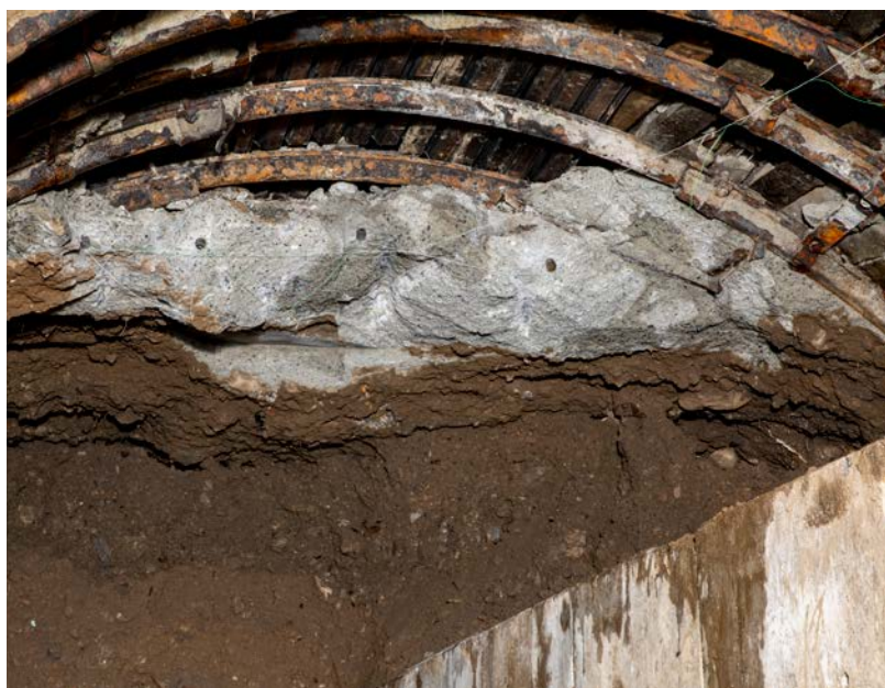
Betonová vrstva v čelbě s připravenými expandéry
