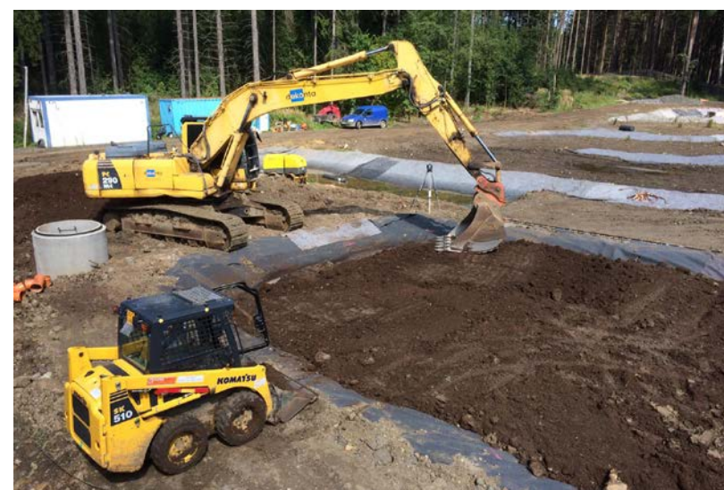
Plnění nádrže D sorpčního remediačního systému substrátem
