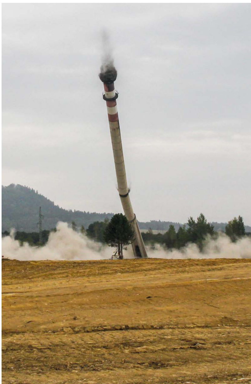
Odstřel komínu ukončil likvidaci areálu DH I
