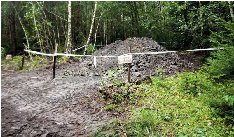
Komín 6-1/0-6 po provedení likvidace propadu
