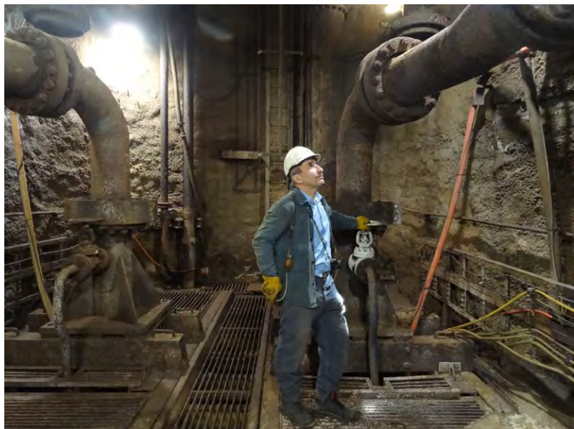
Kontrola potrubí s důlní vodou na jámě Jeremenko
