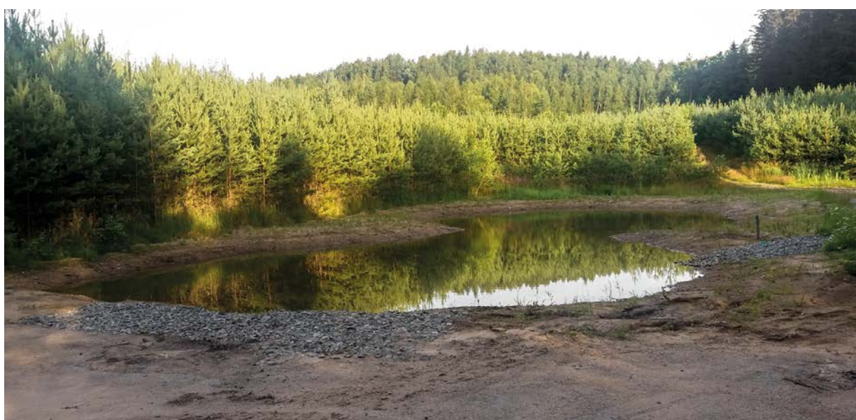
Nahoře: Dolní jímka před likvidací (r. 2018)
