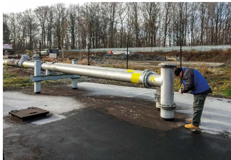
Pravidelný monitoring HDD Jáma Řepiště, autor: Tomáš Mičulek
