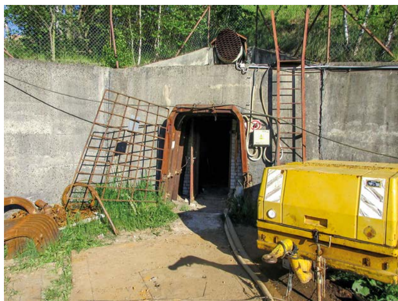
Úvodní přístupová část štol Amália pod tělesem odkaliště
