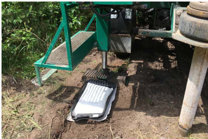
Sorpční polštář pod hydraulickou vrtnou soupravou
