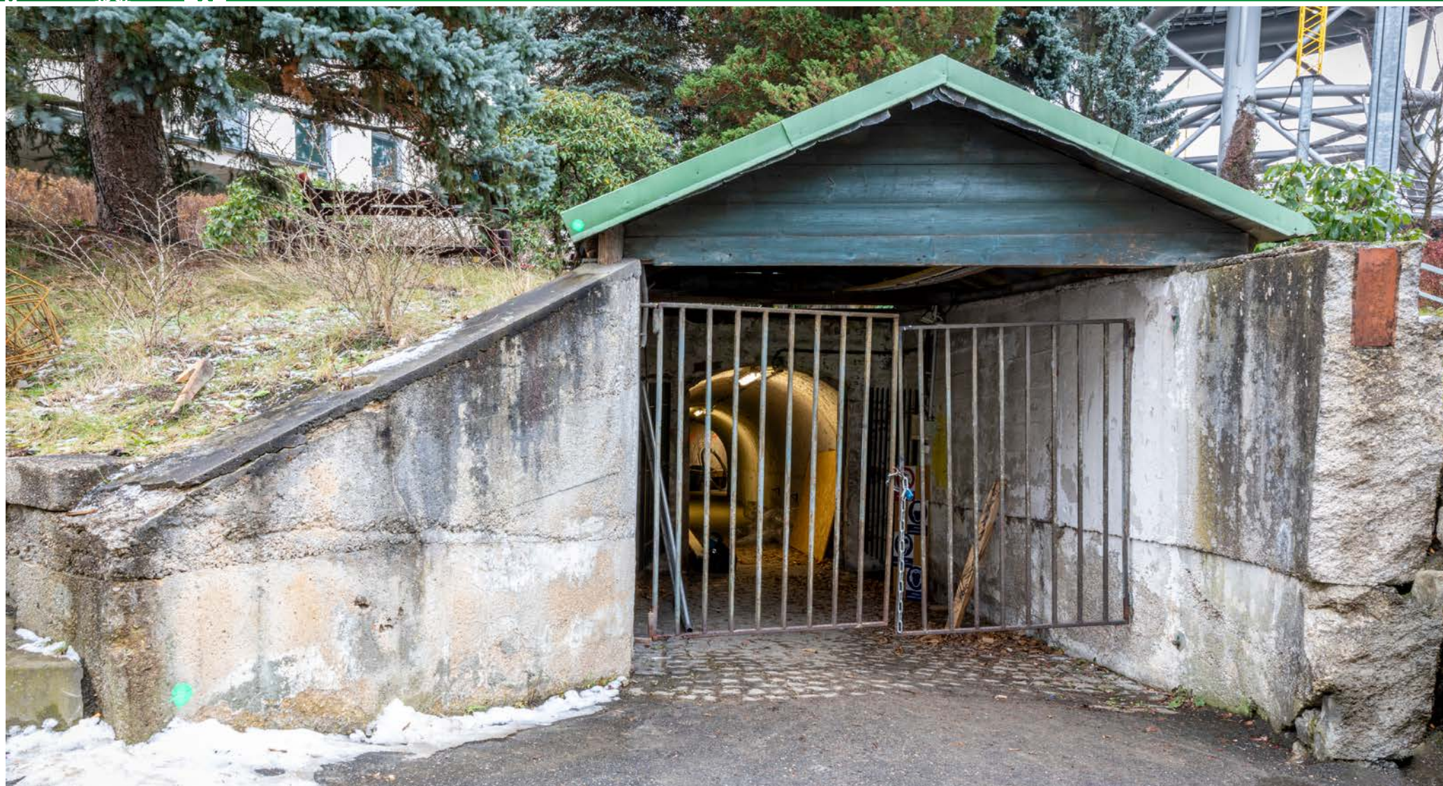
Vstup do podzemního kolektoru v areálu nemocnice
