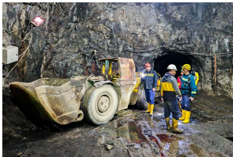
Podzemí dolu Stan Terg s nakladačem Epiroc ST2
