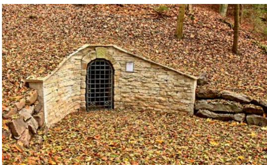
Celkový pohled na hotové dílo
