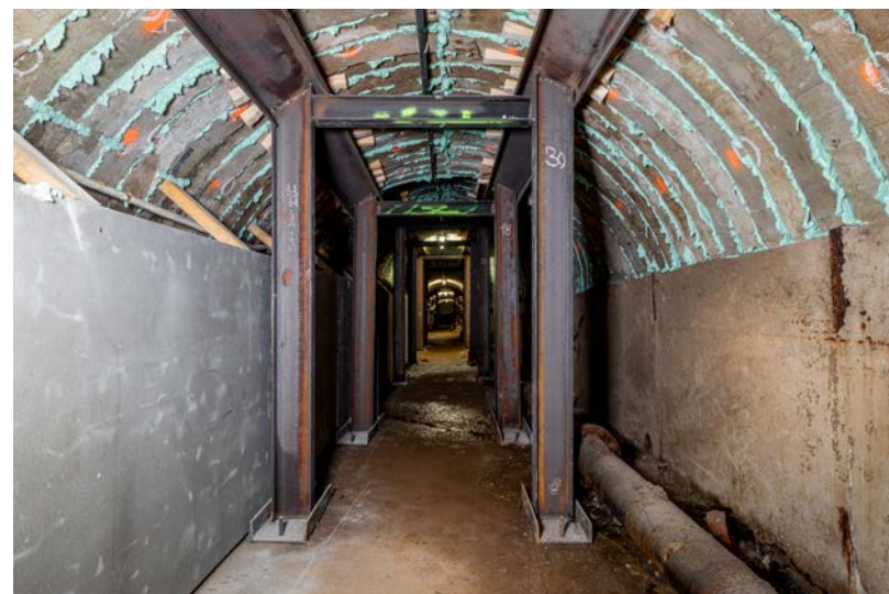
Ocelová výztuž uvnitř kolektoru
