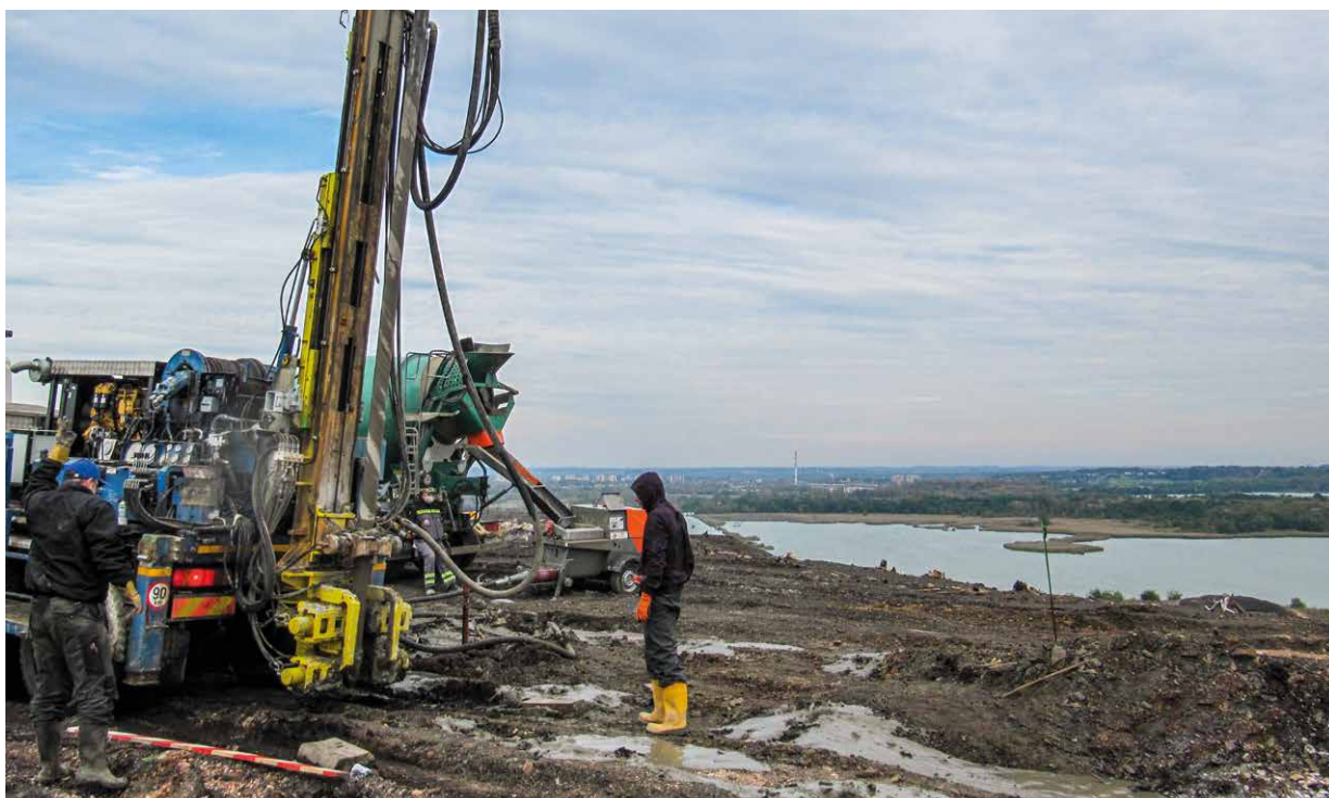
Injektáž na heřmanické haldě
