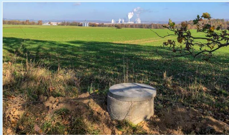
Skrůž chránící monitorovací bod na státní hranici u obce Uhelná
