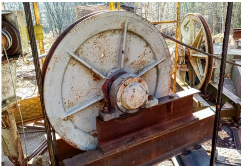
Lanovnice dopravních zařízení na ohlubní jámy R 6
