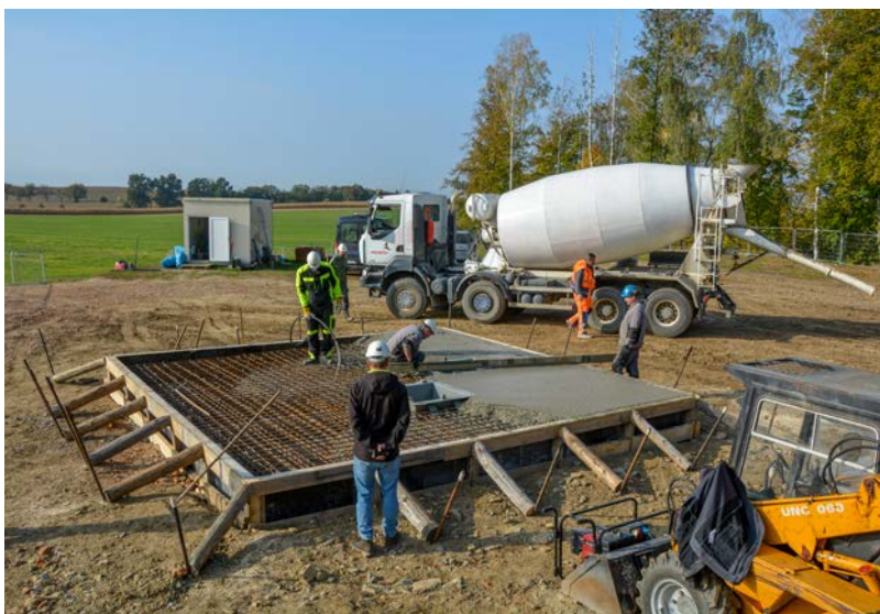
Betonáž uzavíracího ohlubňového povalu
