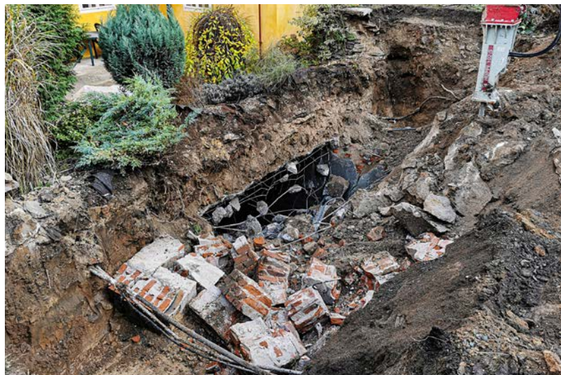
Destrukce a bagrování jámky
