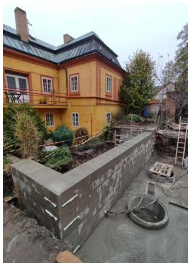
Celkový pohled před zavážením
