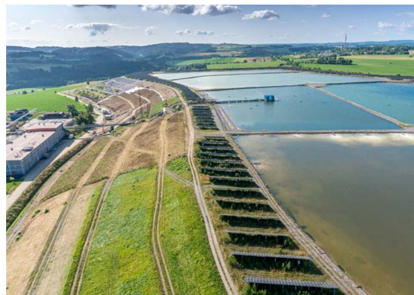
Probíhající rekultivace na vzdušném lici odkaliště K I, Dolní Rožinka, o. z. GEAM
