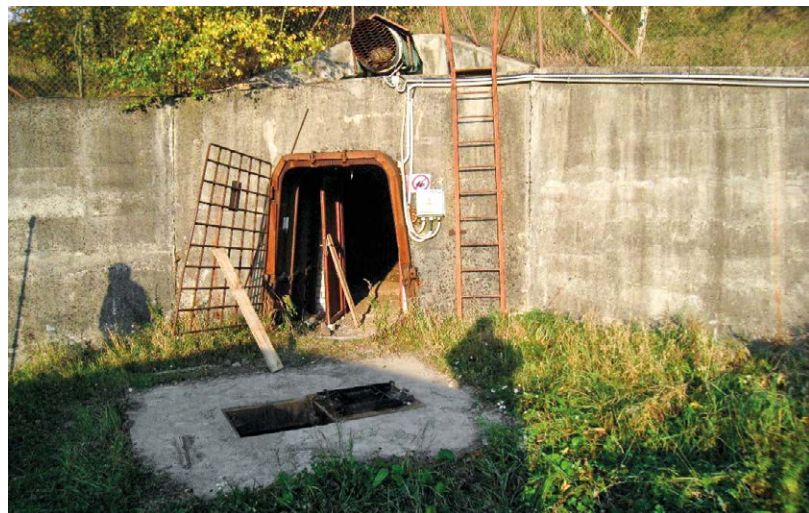
Původní železobetonový portál štoly Amálie s šachticí Š41A
