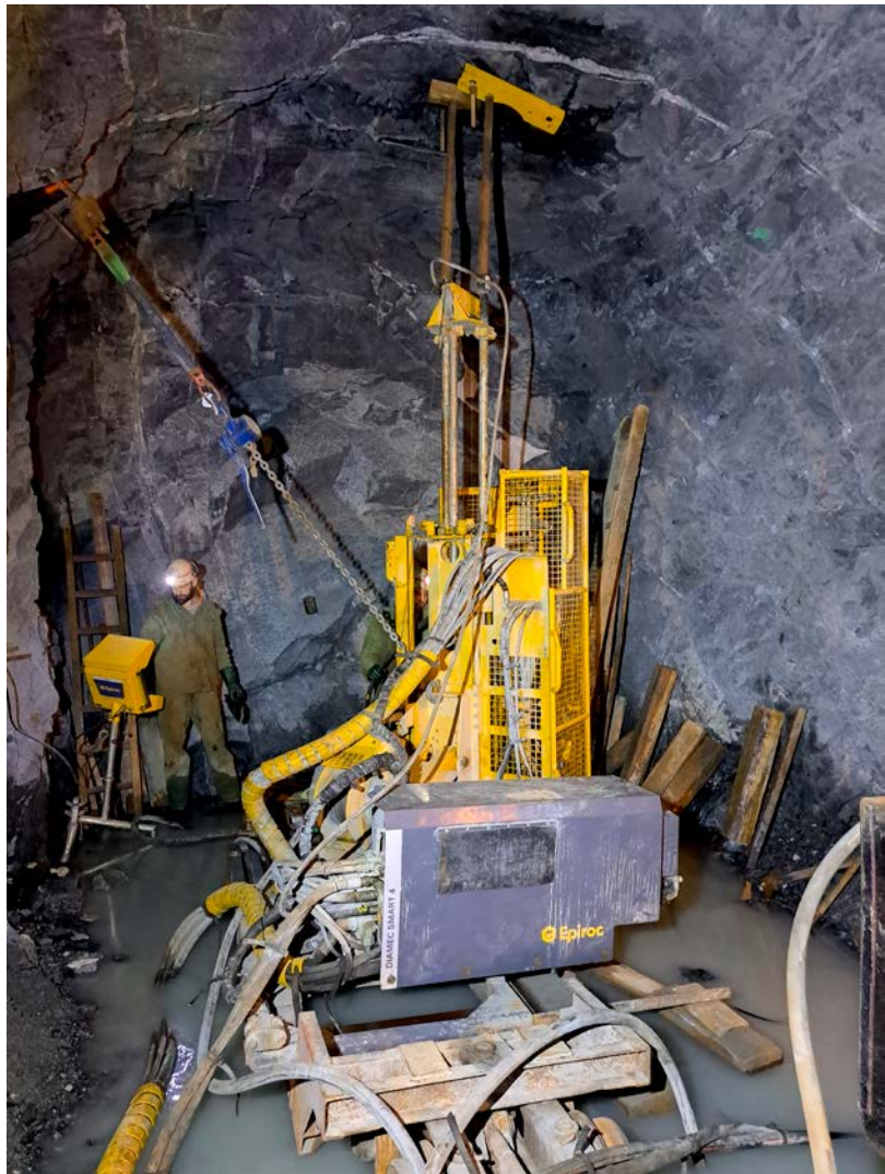
Vrtací souprava Epiroc v plném provozu
