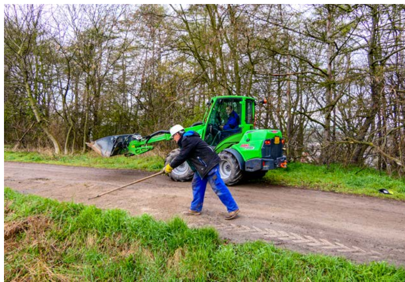
Uvedení povrchu cyklostezky do původního stavu
