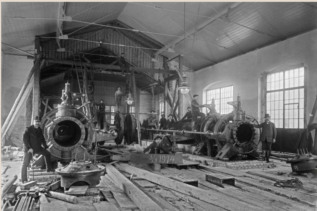
Stavba nového těžního stroje na dole Anna – stav k 3. 3. 1914
