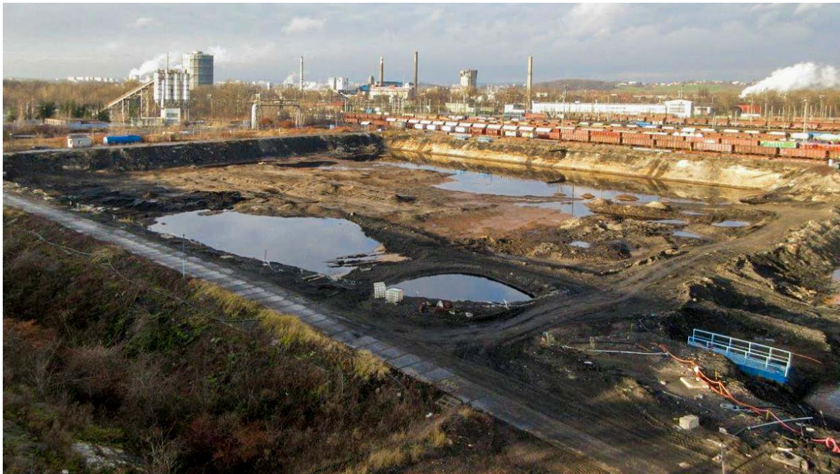
Laguna R3 po odtěžení náplně nadbilančních kalů
