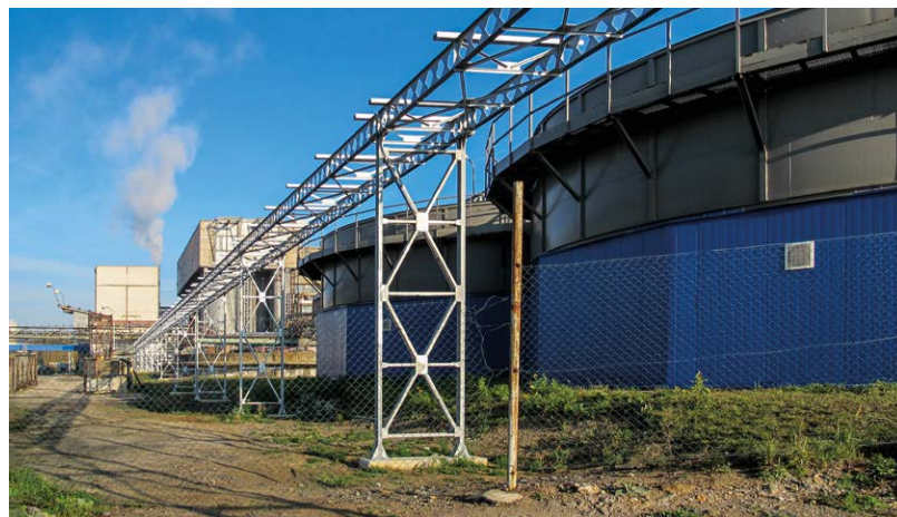
Nový potrubní most na odkališti K II
