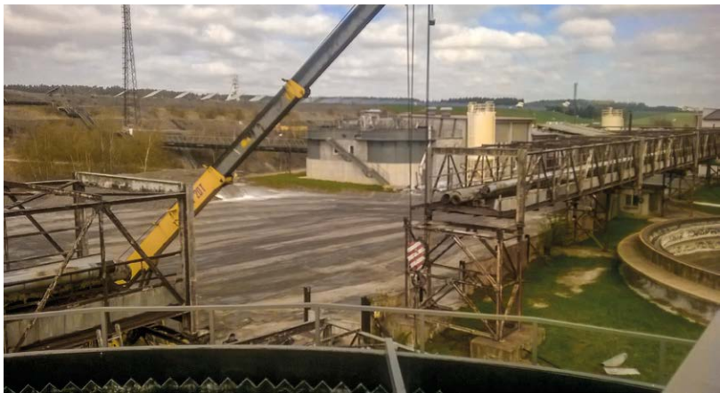
Demontáž starého mostu na odkališti K II
