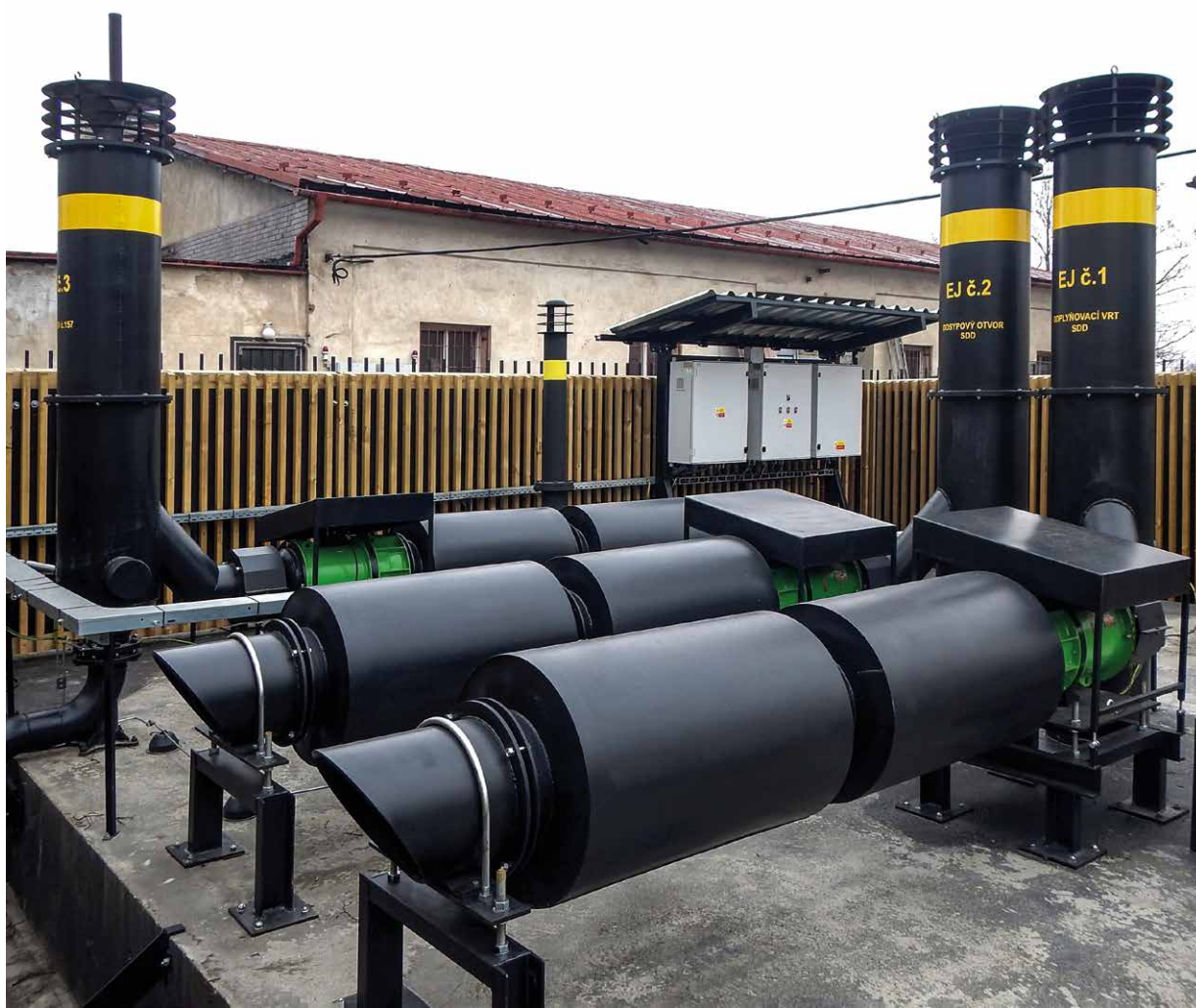
Aktivní odplynovací systém na SDD Michálkovičká v Ostravě
