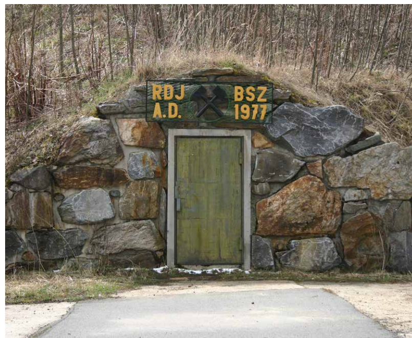
Portál úvodní úpadnice Ú 2401 ve Zlatých Horách
