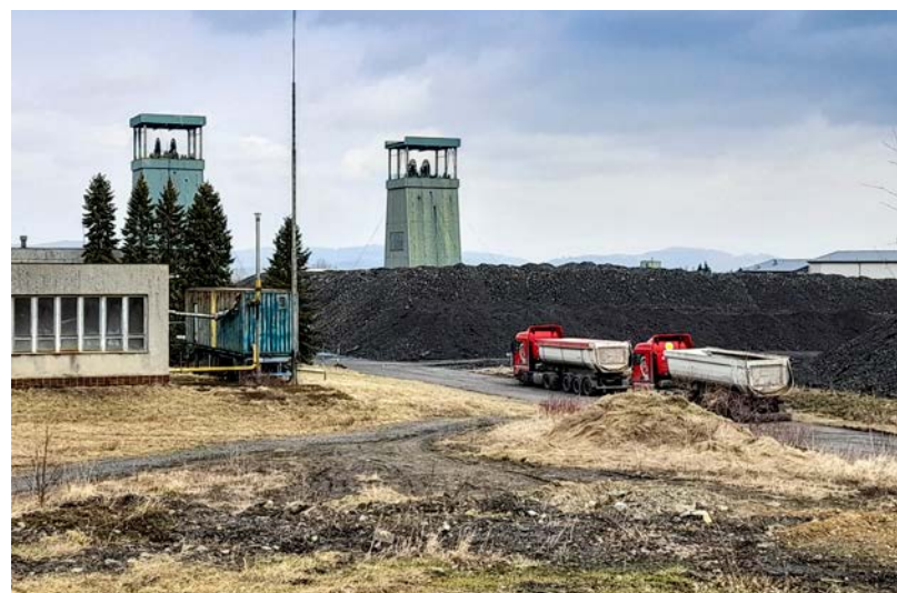
Hlušina připravená na zásyp jam Dolu Frenštát
