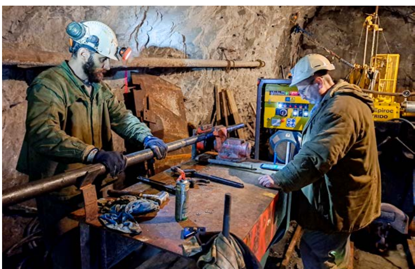
Orientované vrtání v laboratorní chodbě L4A
