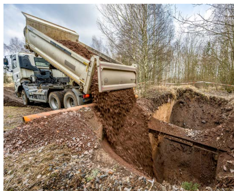
Průběh likvidace propadu zásepem
