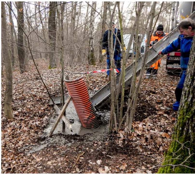
Proplachová zkouška jednoho z propadů
