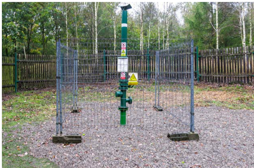
Světlík II, konečný stav po sanaci
