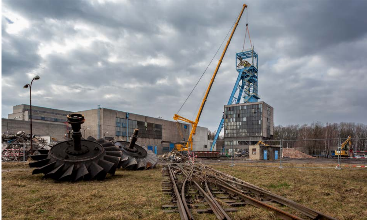
Demontáž vrchní části těžní věže v Chlebovicích
