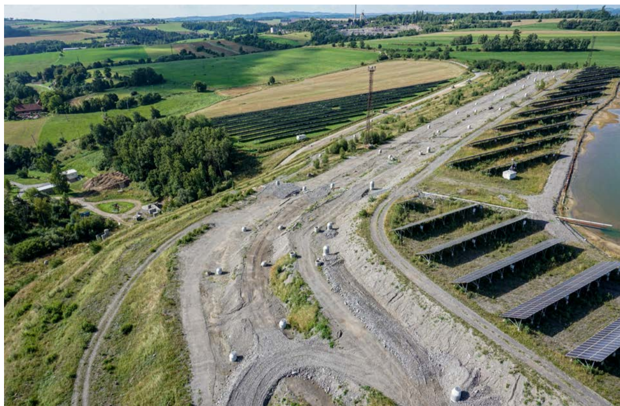
Jímací zářezy na vzdušném líci hlavní hráze K I
