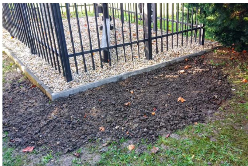
Větrní jáma č. 10, finální zajištění propadu
