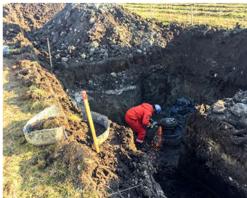
Úprava ústí sondy
