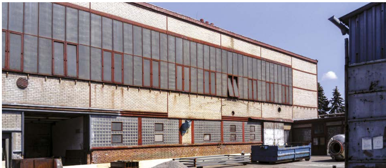
Budova dílen před rekonstrukcí
