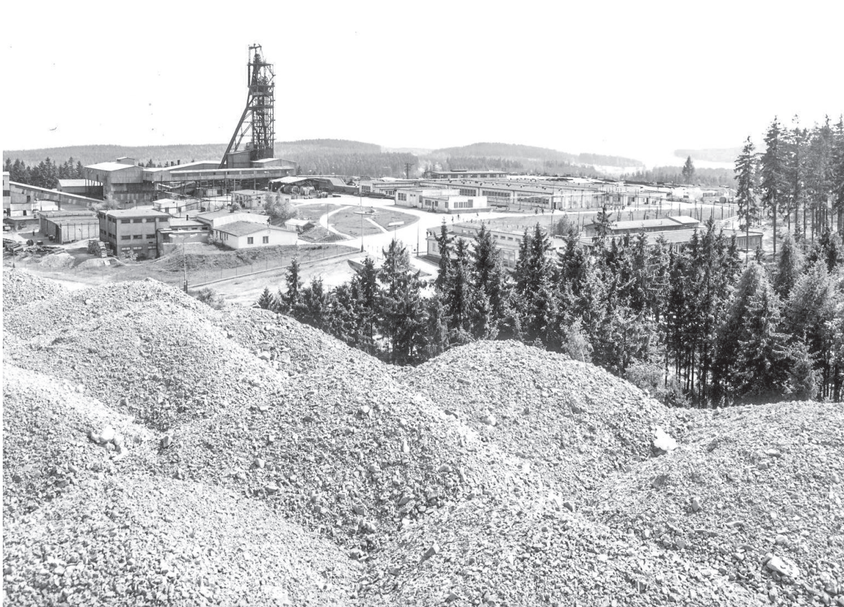
Šachta č. 16, areál
