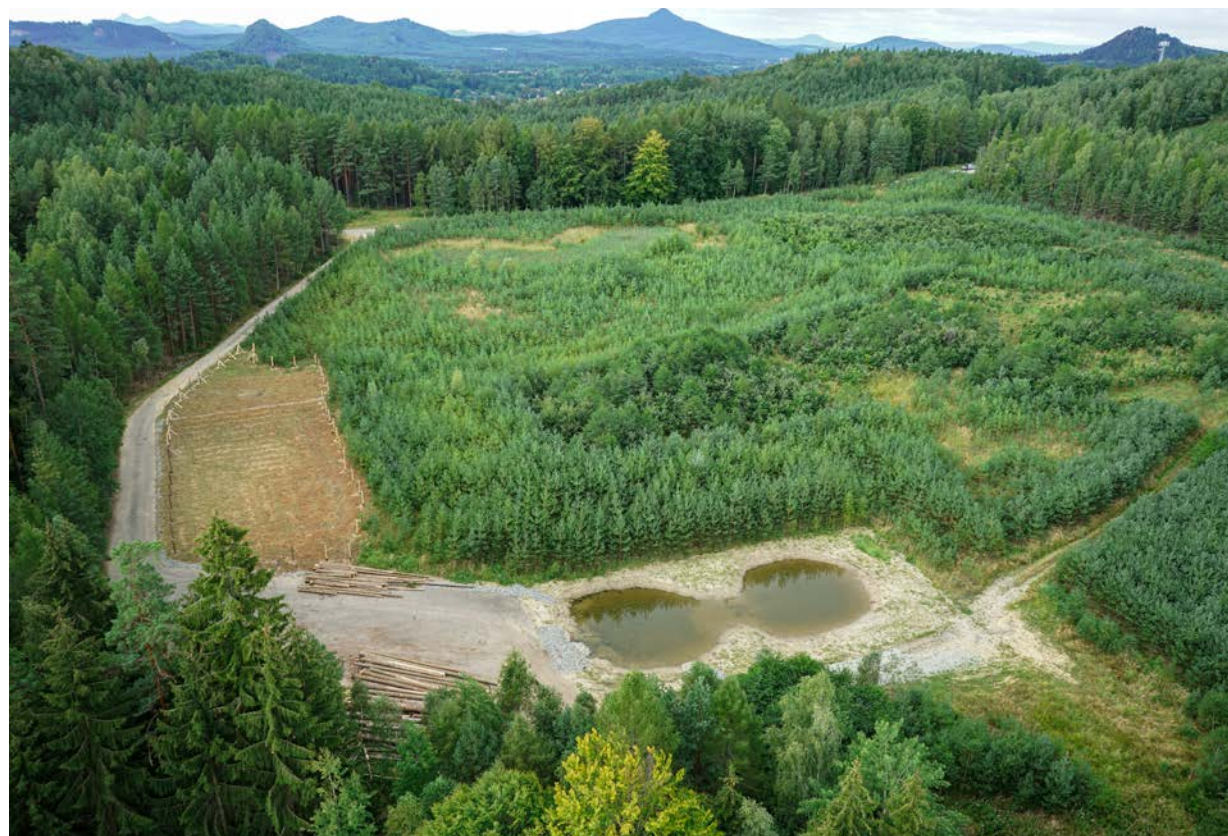
Areál bývalého Dolu Křižany I, o. z. TÚU, Stráž pod Ralskem
