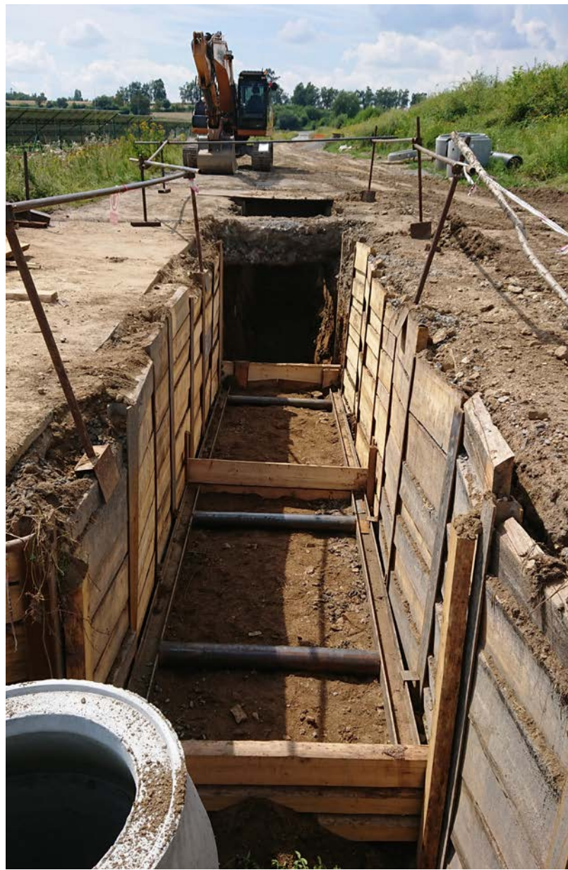
Úsek obnoveného patního drenážního systému v záporovém pažení před dokončením zásypu
